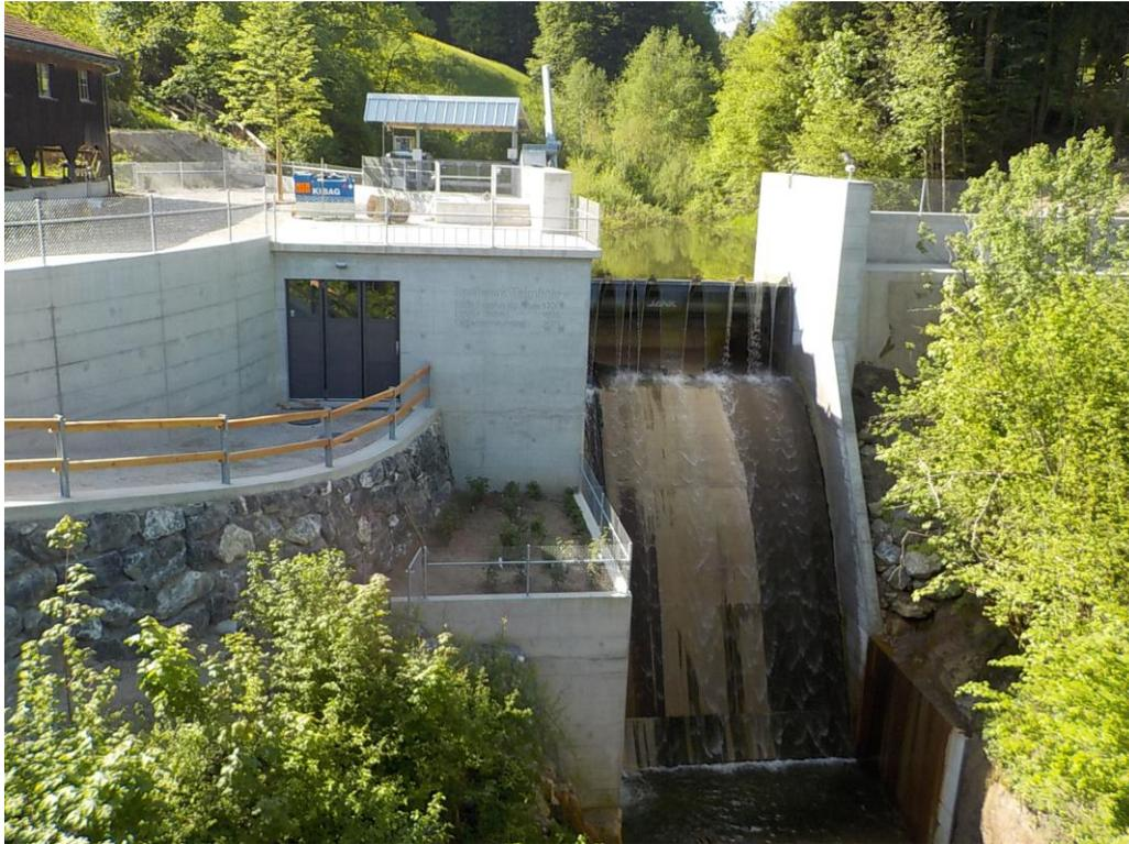
Abbildung 9 Kraftwerk Talmühle mit Geschiebeklappe (Foto Beat Müller, 20.5.2022)
