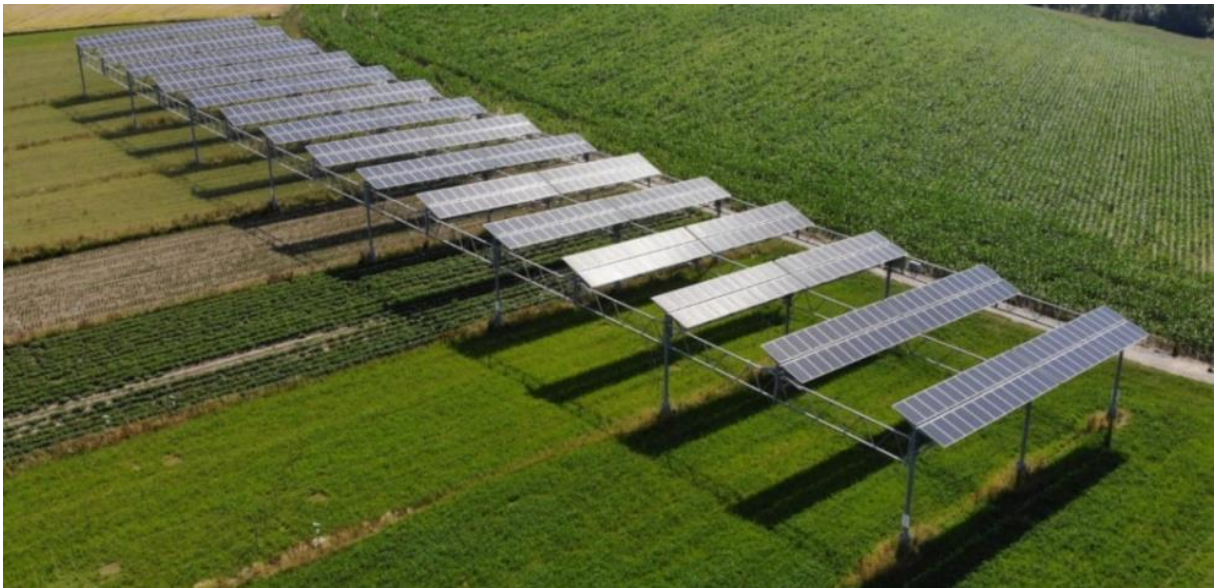
Abbildung 2: Anlagenbeispiel für Bewirtschaftungsstatus "Offene Ackerkultur". Agri-PV-Versuchsanlage (APV Resola) mit festinstallierten Modulen in Heggelbach (Deutschland). Die Module sind auf einer Höhe von 5.5 m installiert und der Stützenabstand in der Längsrichtung beträgt 19 m (Hofgemeinschaft Heggelbach, o. J.).
