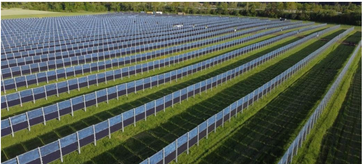
Abbildung 3: Anlagenbeispiel für den Bewirtschaftungsstatus "Dauergrünland". Vertikale APV-Anlage von Next2Sun in Donaueschingen (Deutschland). Die bifazialen Module sind vertikal aufgeständert, Ausrichtung der Modulflächen nach Osten bzw. Westen, Reihenabstand 10 m (Next2Sun, 2020).
