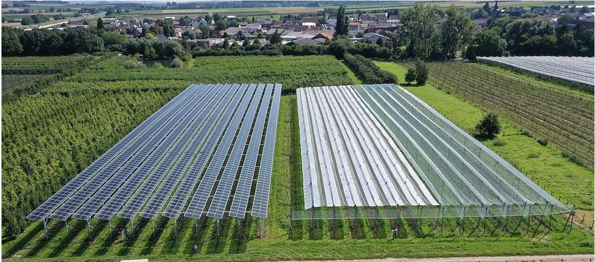
Abbildung 4: Anlagenbeispiel für Bewirtschaftungsstatus "Dauerkulturen" und «geschützter Anbau». Agri-PV-Anlage über einer Obstplantage in Gelsdorf (DE). Mit der APV-Anlage (links im Bild) konnten bestehende Kulturschutzmassnahmen (rechts im Bild) substituiert werden (Energie-Experten, o. J.).
