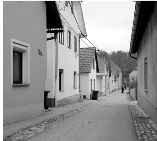
Abb. 1-3: Traditionell verdichtete Einzelhausbebauung in Krakovo, Ljubljana.
