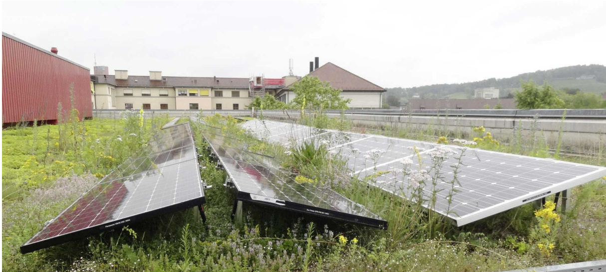
Abbildung 5: Gutes Beispiel einer schlechten Umsetzung eines Solar-Gründaches Quelle: Prof. Dr. Hartmut Nussbaumer und Dr. Markus Klenk; bullentin.ch
