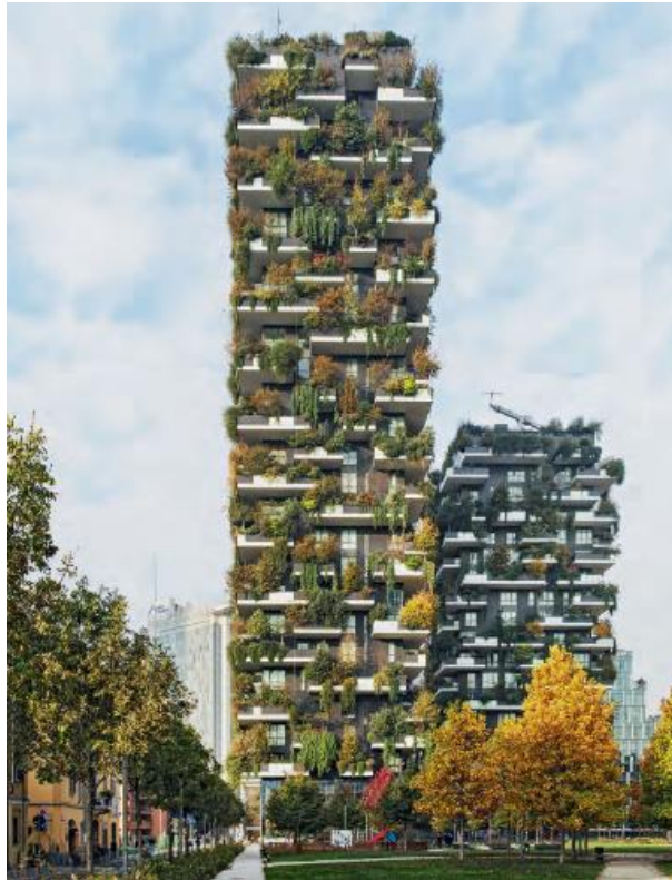
Abbildung 1: Die beiden Türme des Bosco Verticale Quelle: (Schröpfer, 2020)
