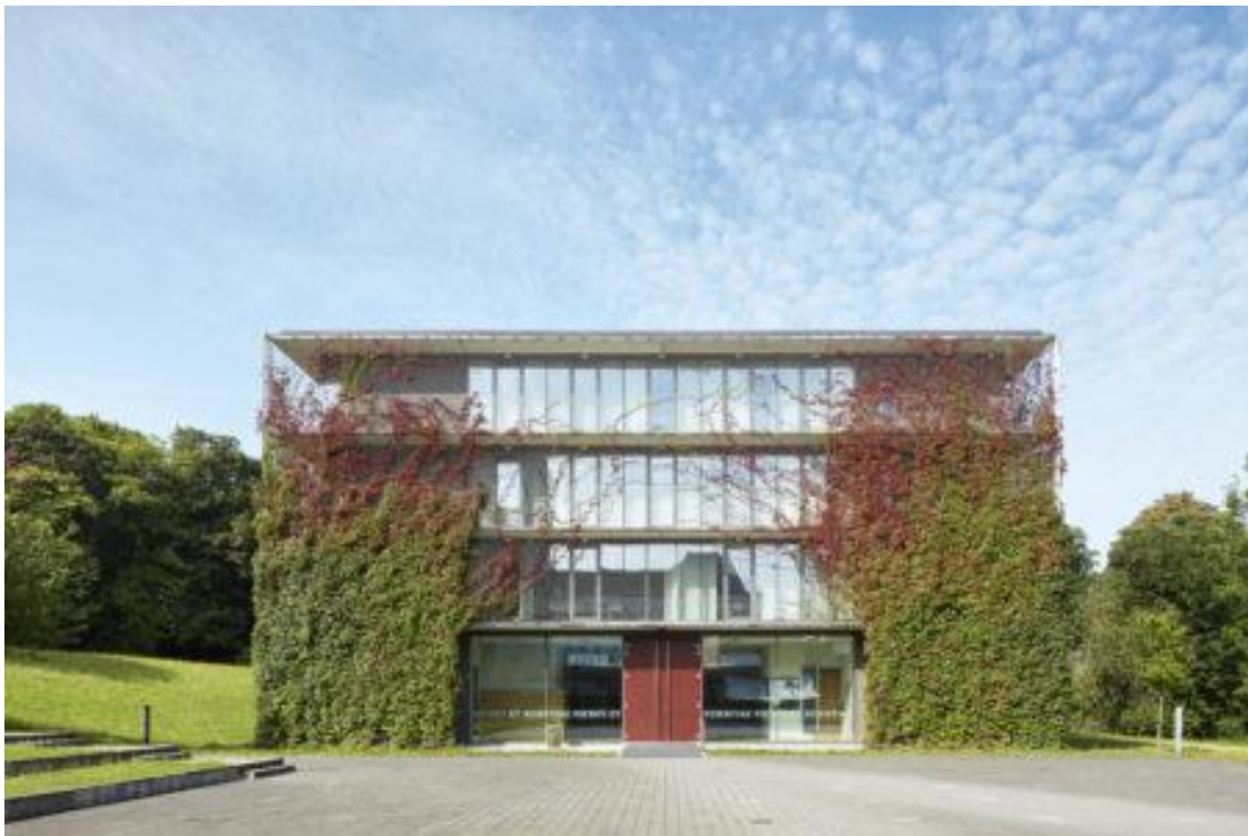
Abbildung 11: Institutsgebäude PTH St. Georgen
