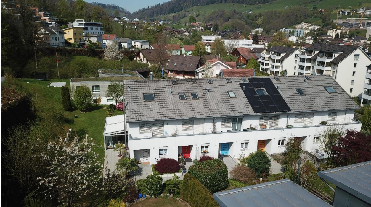
Abbildung 6: Ansicht auf die Ostseite eines Daches an der Houelbachstrasse
