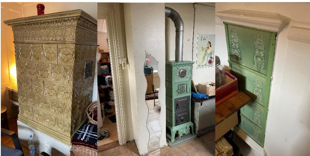
Abbildung 24: Holzöfen im Referenzgebäude. Der Kachelofen, links im Bild, wird über einer Heizkassette in der gegenüberliegenden Küche eingefeuert. Der Zimmerofen (mittig im Bild) ist in die Wand eingebaut und heizt dadurch nebst dem Aufstellraum auch das gegenüberliegende Zimmer (Rechts im Bild).
