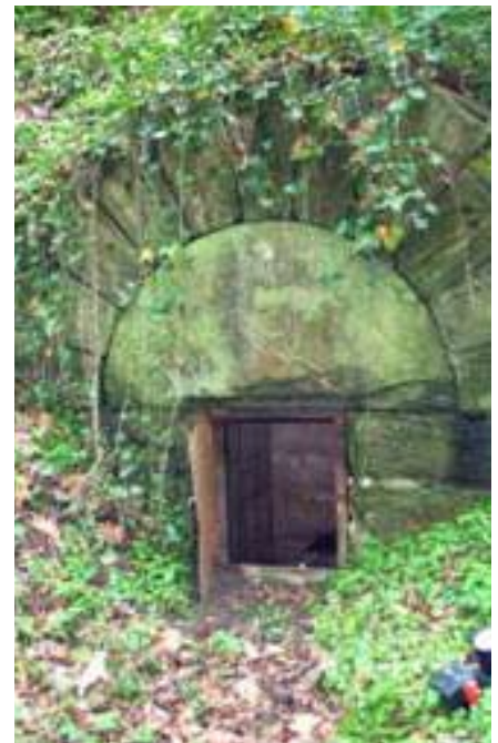
Ungefasste Quelle (oben); Eingang zur gefassten Quelle (unten)
