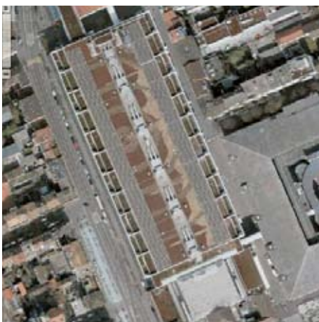
Die Luftaufnahme kurz nach Ausbringung der Substrate (Bild: GeoPortal Stadt Basel)
