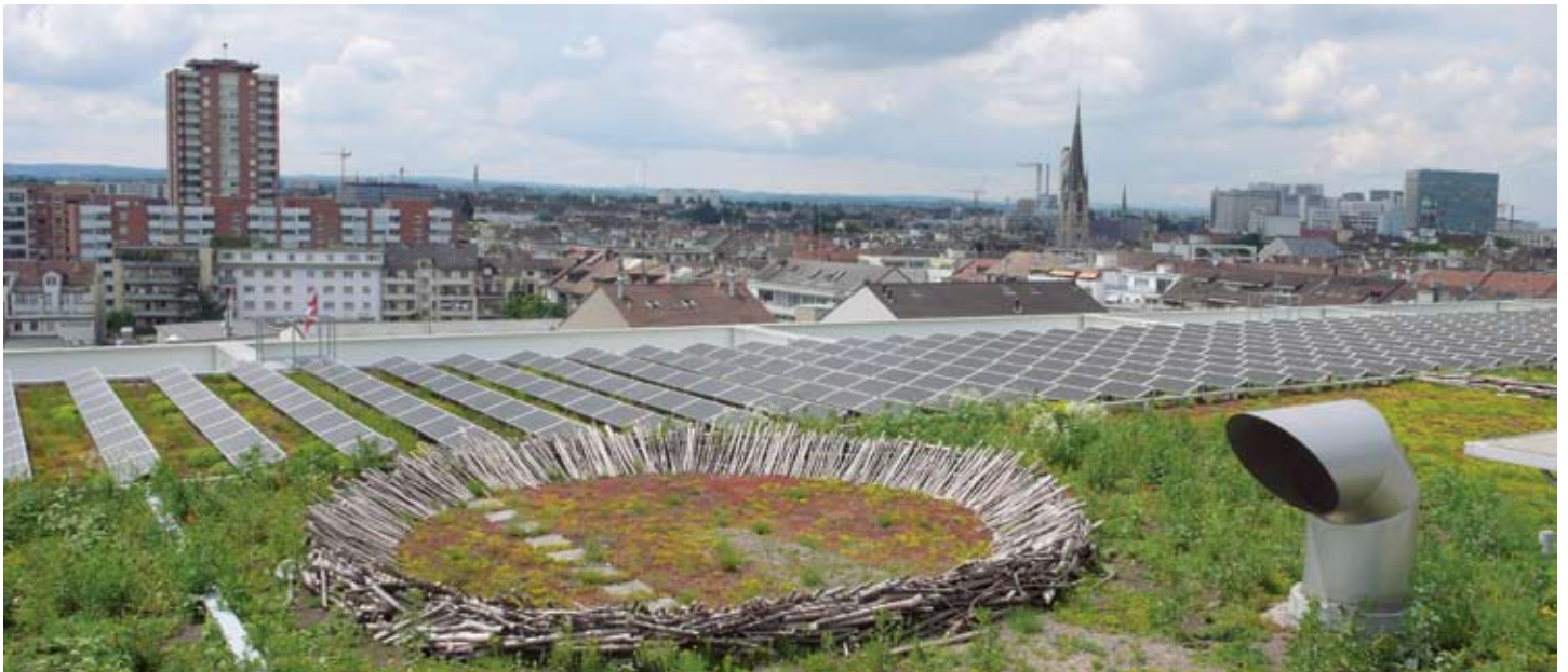
Landart geht Hand in Hand mit der ökologischen Aufwertung Im Hintergrund: Photovoltaikanlage (Bild: Michael Zogg)
