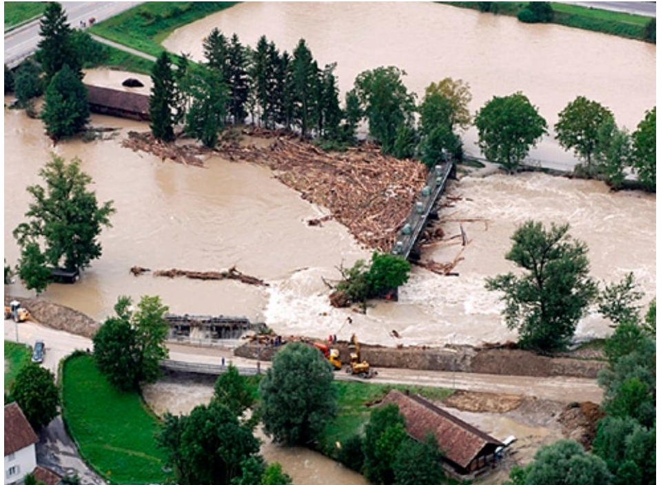
Hochwasser Reuss: Verklausung beim Wehr Perlen am 23. August 2005 (Bild: Schweizer Luftwaffe, Flug 050823, Bildnummer: 20056531)
