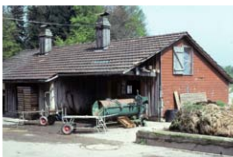
1978: Schweinestall vor dem Umbau zum Rüst- und Arbeitsraum, davor Karottenwaschmaschine
