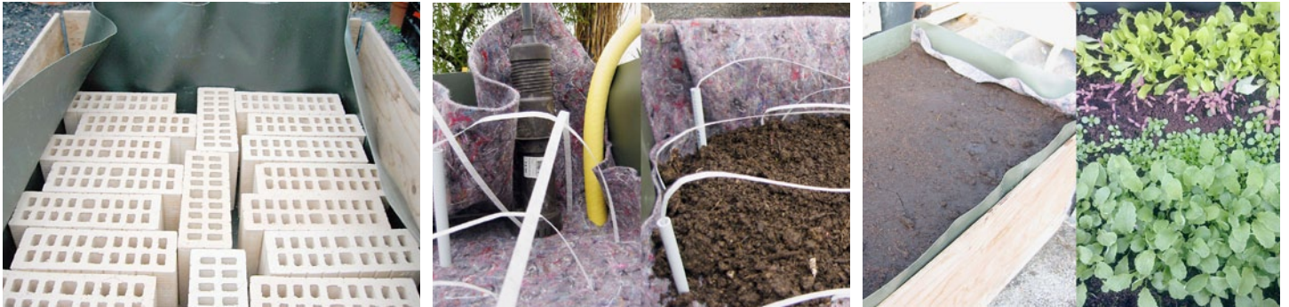
Der Bau von Testbeete, Wädenswil (Bilder: Franziska Matter)
