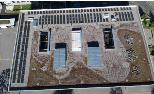
Abb. 4 Das Schulhaus Schoren weist grösstenteils spärlich bewachsene oder offene Kiesflächen auf. Einige Totholzstrukturen sind auf den offenen Flächen vorhanden.
