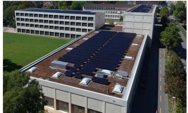
Abb. 5 Das Schulhaus Sandgruben weist einen sehr hohen Blähton-Anteil auf. Der Bewuchs beschränkt sich ausschliesslich auf Sedum. Strukturen jeglicher Art sind keine vorhanden.
