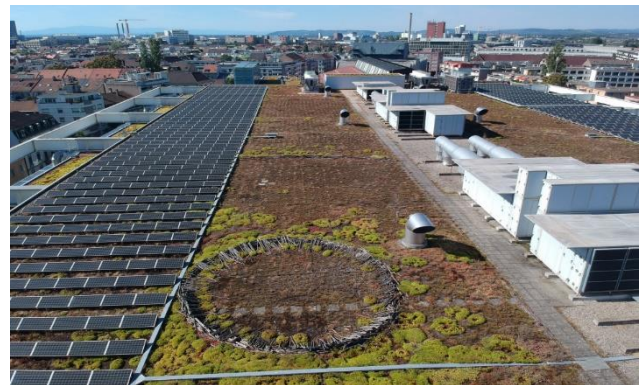
Abb. 7 Das Messedach Halle 1 verfügt über drei unterschiedliche Teilbereiche, PV, Holz und offen. Das gesamte Dach ist relativ spärlich mit Sedum bewachsen. Flächen mit höherer Vegetation gibt es nur sehr wenige.
