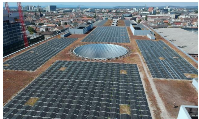
Abb. 9 Das Messe H&DeM-Dach ist grösstenteils mit dichten PV-Anlagen bedeckt. Die verbleibende Fläche ist sehr gering bewachsen, hauptsächlich mit Sedum. Strukturen sind kaum vorhanden.
