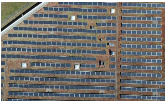
Abb. 8 Das Prodega-Dach (Nr. 4) ist vollständig mit PV-Anlagen ausgestattet. Die Vegetation beschränkt sich ausschliesslich auf Sedum. Des Weiteren weist das Dach einen hohen Blähton-Anteil auf.
