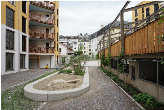
Abbildung 7: Innenhof (Eigenes Bild)
