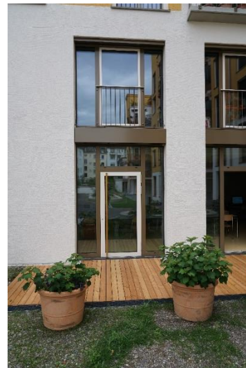
Abbildung 10: Fassaden und Gewerberäume (Eigenes Bild)
