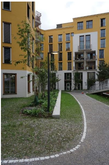
Abbildung 9: Innenhof (Eigenes Bild)
