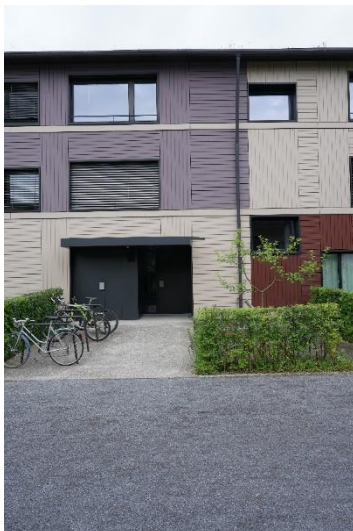
Abbildung 5: Südseite Gebäude (Eigenes Bild)
