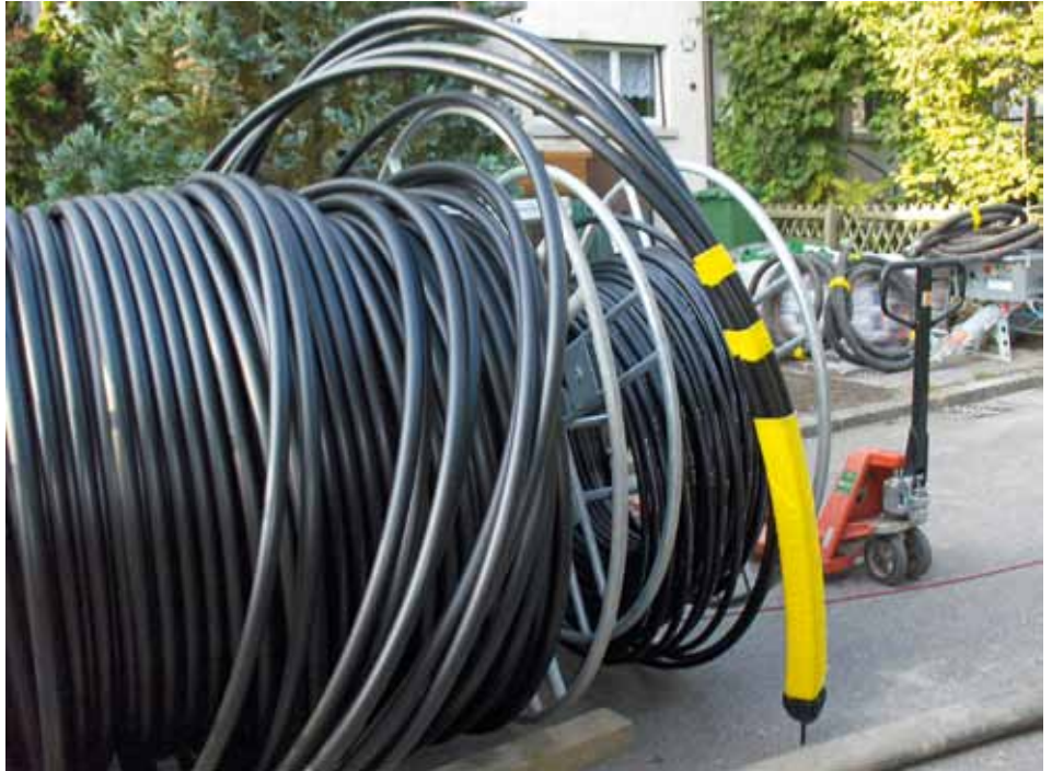
Erdwärmesonde bereit zum Einbau in ein Bohrloch.
