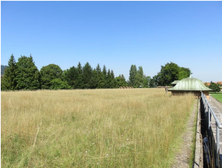
Abbildung 14: Dach 1 Seewasserwerk Moos
