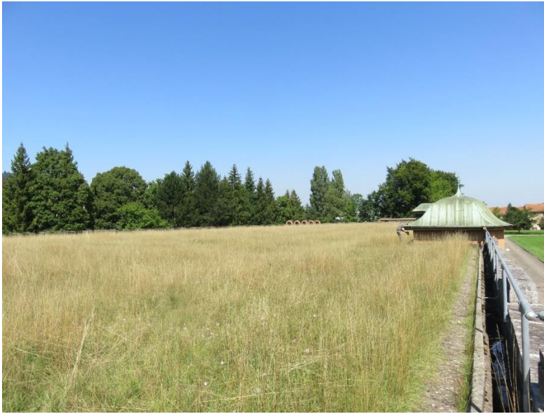
Abbildung 25: Dach 1 Seewasserwerk Moos
