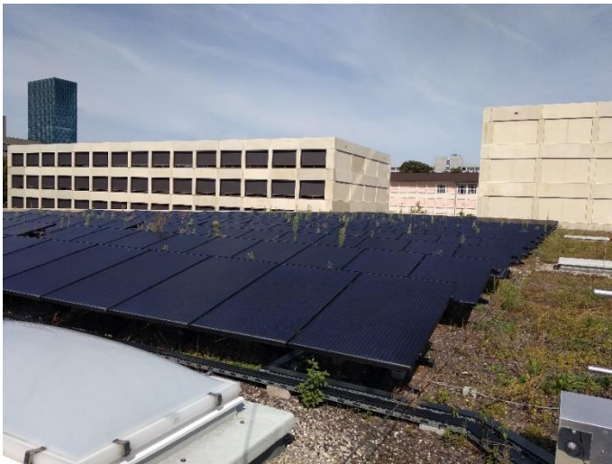
Abbildung 12: Dach des Schulhaus Sandgruben
