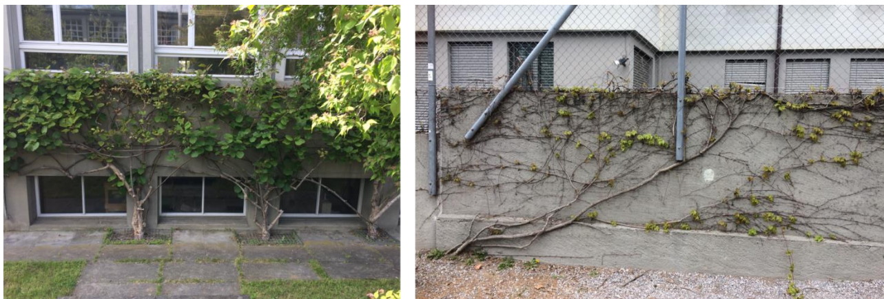
Abbildung 30 Kletterpflanze an Drähten gezogen (Bild 1: Kiwi) und Direktbewuchs mit Selbstklimmer (Bild 2: Wilder Wein) an Fassade und Mauer, welche sich durch die Vegetation weniger stark erwärmen (eigene Aufnahmen, 2019)
