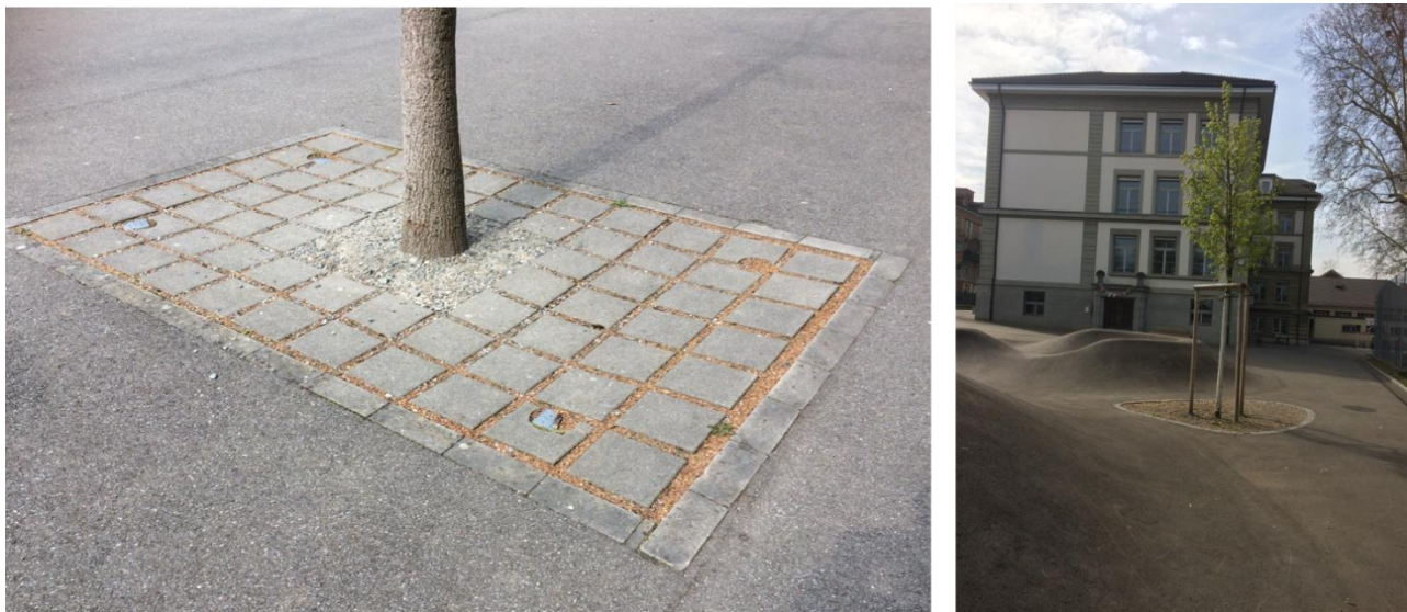
Abbildung 27 Baumscheibe beim Schulhaus Breitenrain (Bild 1) und Pumptrack (Bild 2) beim Schulhaus Lorraine zeigen hohen Versiegelungsgrad und Störungen der natürlichen Entwässerung (eigene Aufnahme, 2019)
