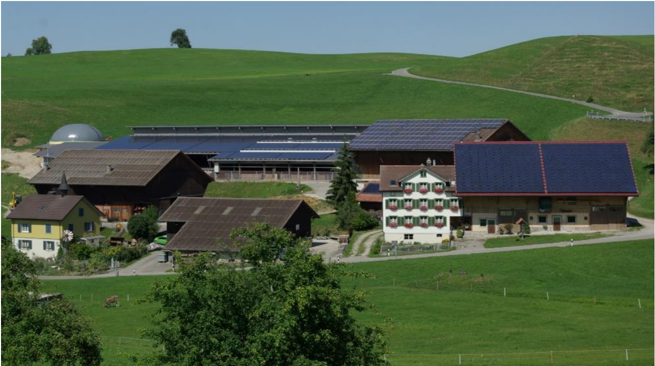
Abbildung 12: Hof Josef Gemperle mit Solar- und Biogasanlage
