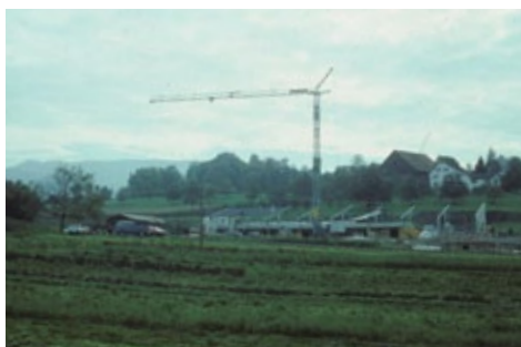
Die im Einstellhalle im Bau.
