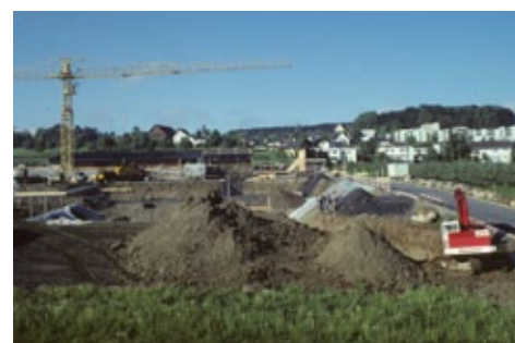
Zufahrtsstrasse mit Baugrube und Kran, im Hintergrund die neue Einstellhalle.
