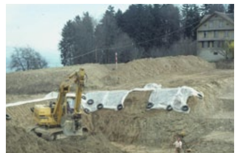
Baugrube mit dem Bauernhaus welches bis 1983 stehen bleibt.
